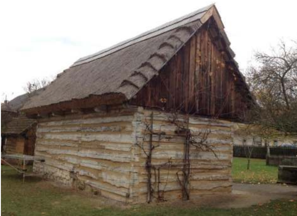
PNM Přerov nad Labem - špýchar z Vlkavy po opravě hliněných vymazávek
