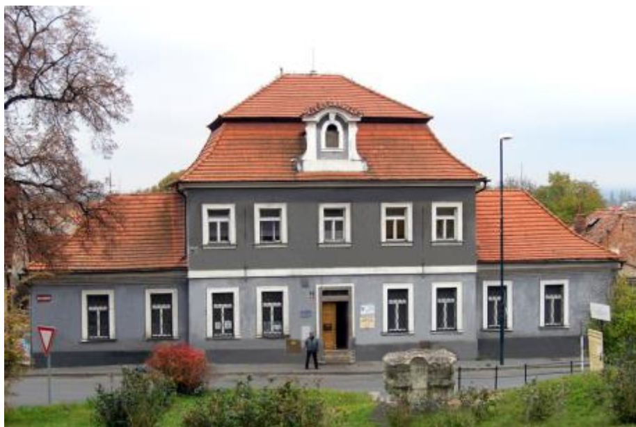
Muzeum Bedřicha Hrozného Lysá nad Labem před rekonstrukcí (2013)
