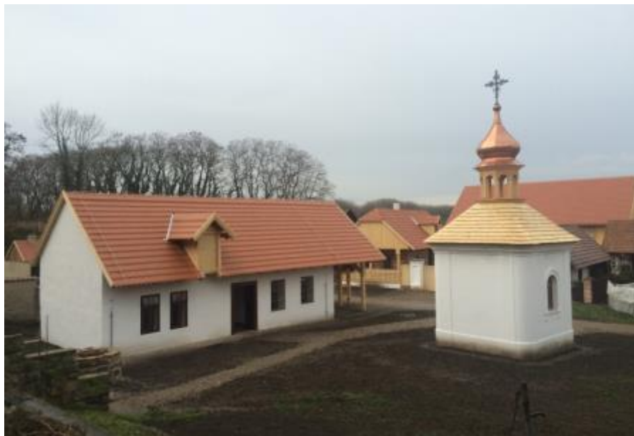
Dokončené stavby v areálu skanzenu (11. 12. 2015)
