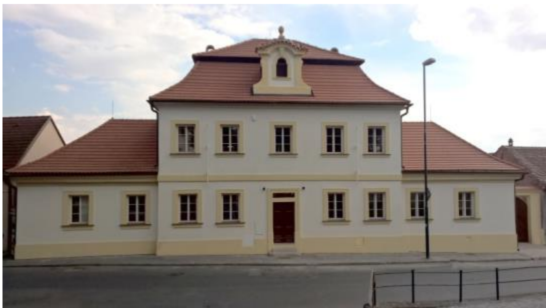
Muzeum Bedřicha Hrozného Lysá nad Labem po rekonstrukci (2015)
